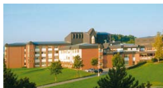
Krankenhaus der Barmherzigen Brüder Montabaur
